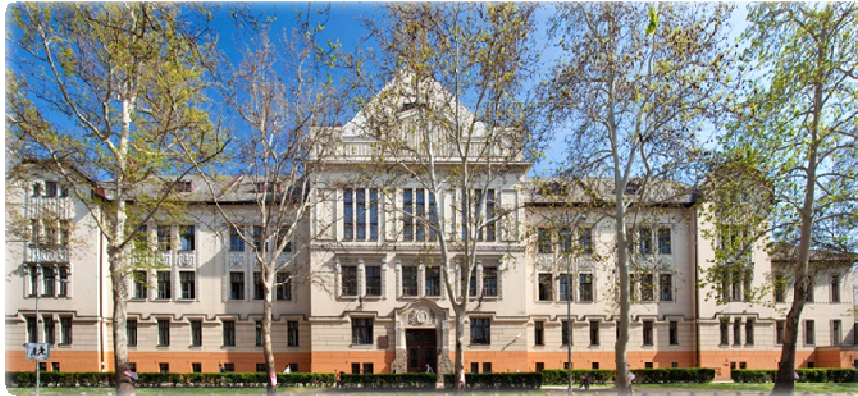
Слика 1: Зграда Електротехничке школе у Футошкој 17
