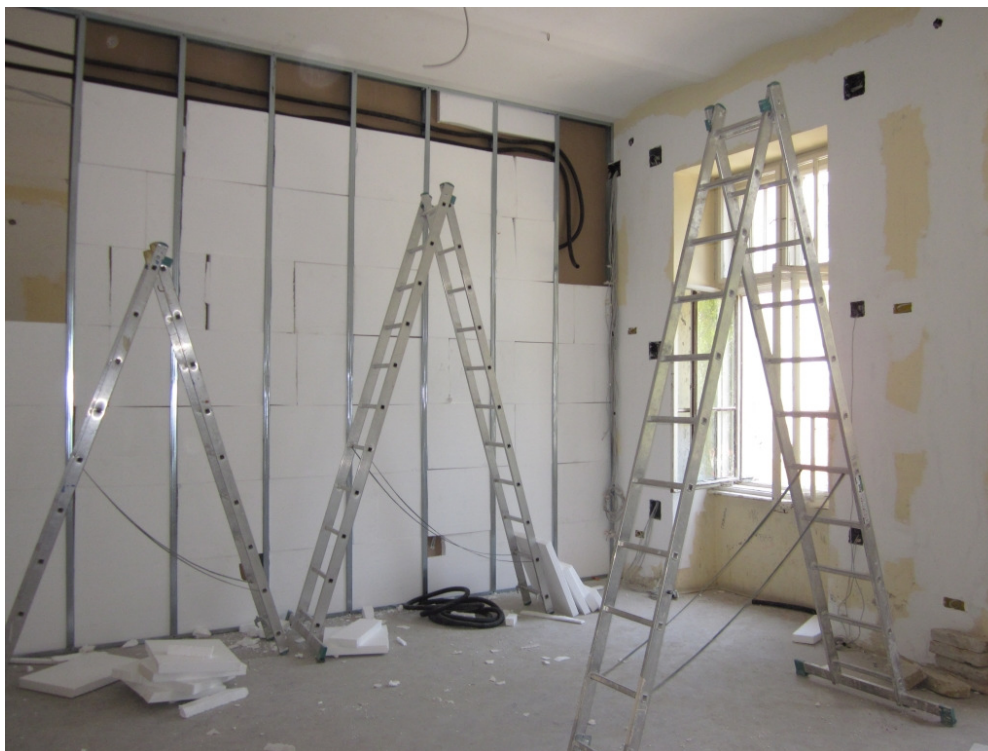
Слика 8: Кабинет 10 у раној фази реконструкције
